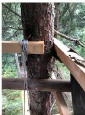
Aufstieg und Sitzgelegenheit mit Nägeln oder Schrauben an den Baum befestigt
