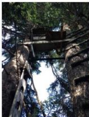
Aufstieg und Sitzgelegenheit mit Nägeln oder Schrauben an den Baum befestigt
